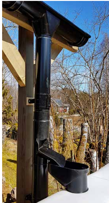
Utkastare och rensträtt innan regnvattnet når IBC-tanken.
