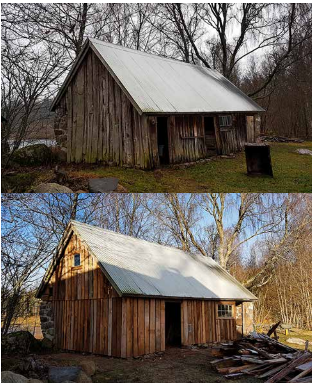
Grisstallet före och efter renovering – det är nu vedbod och plantverkstad.
