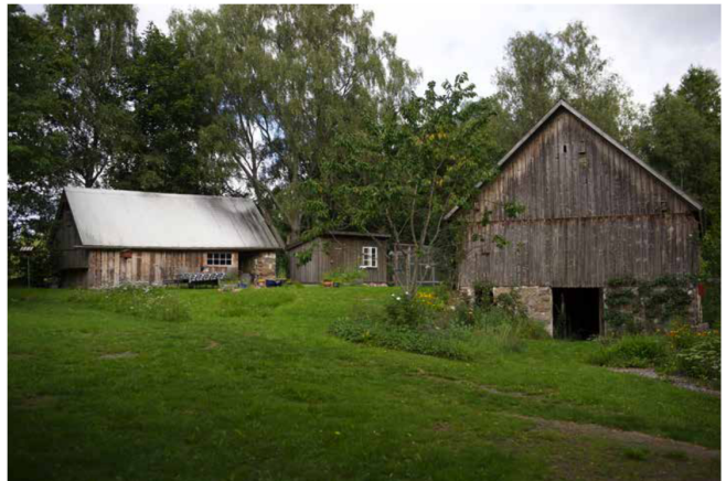
Gården, som paret kallar för Gammelgård, var i stort behov av renovering när de köpte den.
